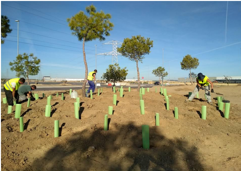
Figura 33. Trabajadores en rotonda colocando protectores y preparando el alcorque con pala.
