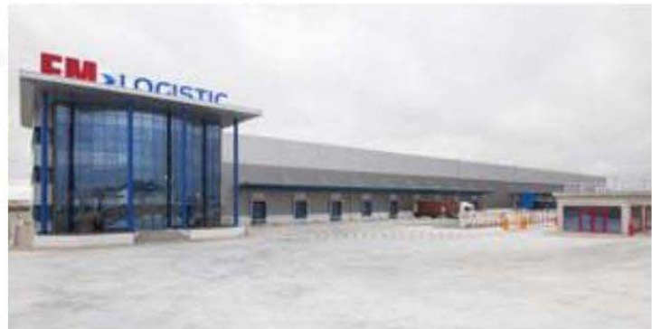
Las nuevas instalaciones del operador en PCI
