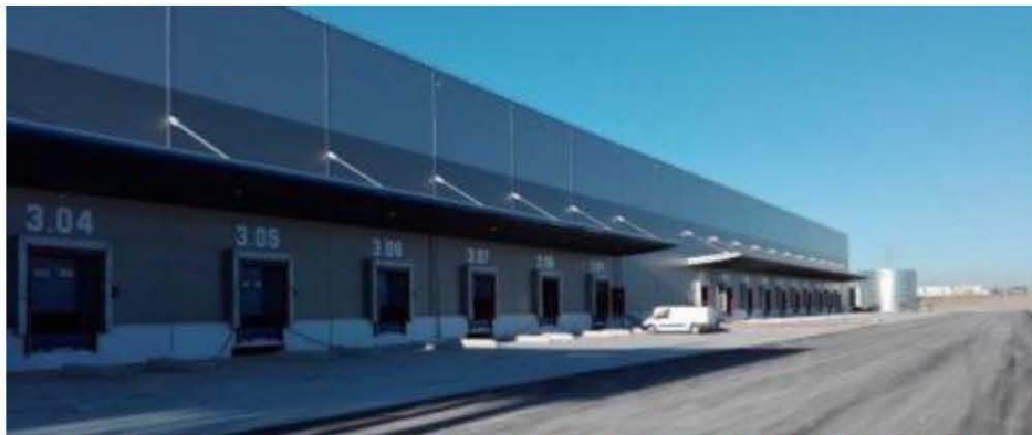
La nueva nave de FM Logistic en Plataforma Central Iberum tiene 22.000 metros cuadrados.
