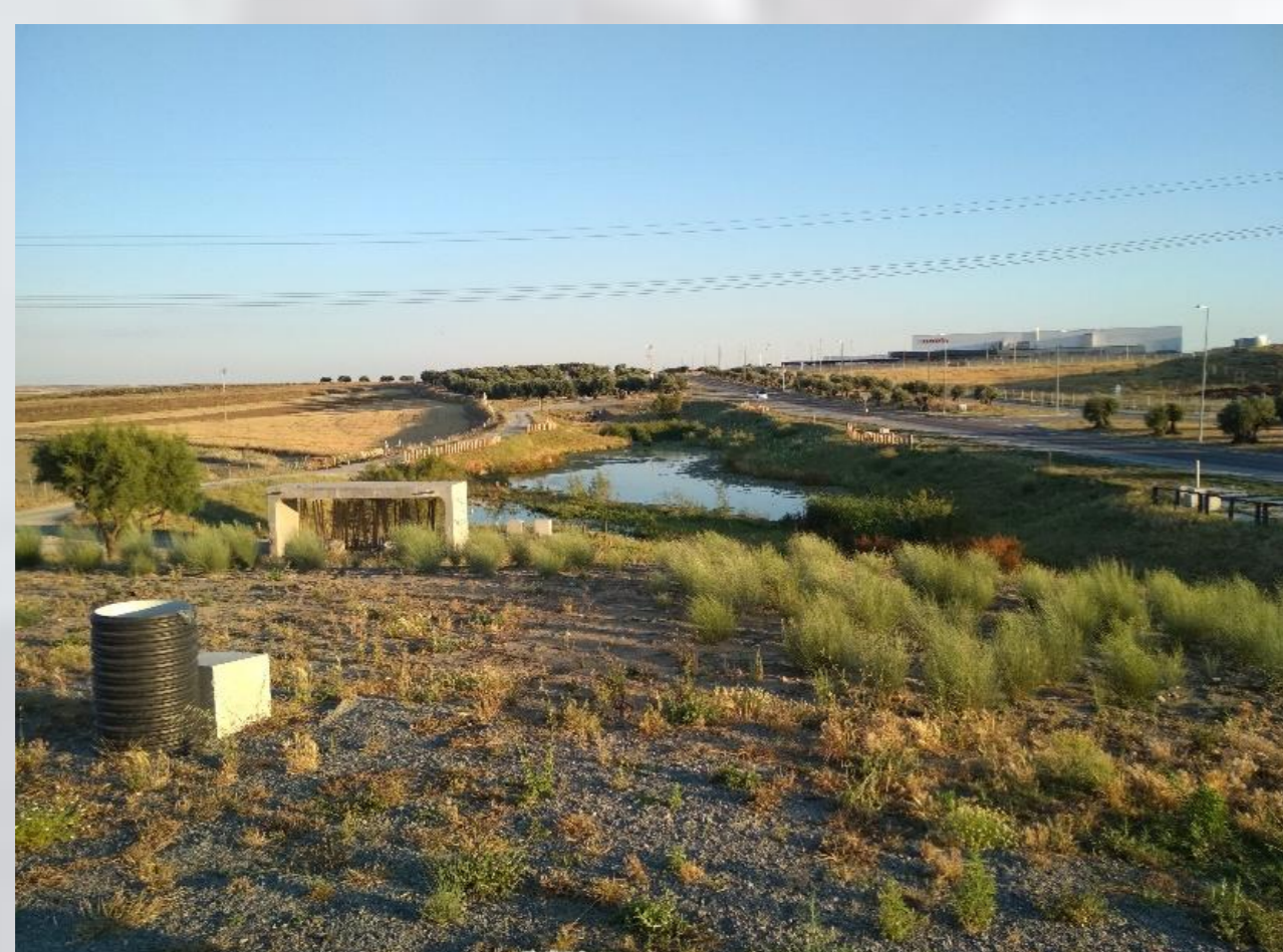
Figura 4. Balsa de pluviales naturalizada (Fase 0) en Plataforma Central Iberum
