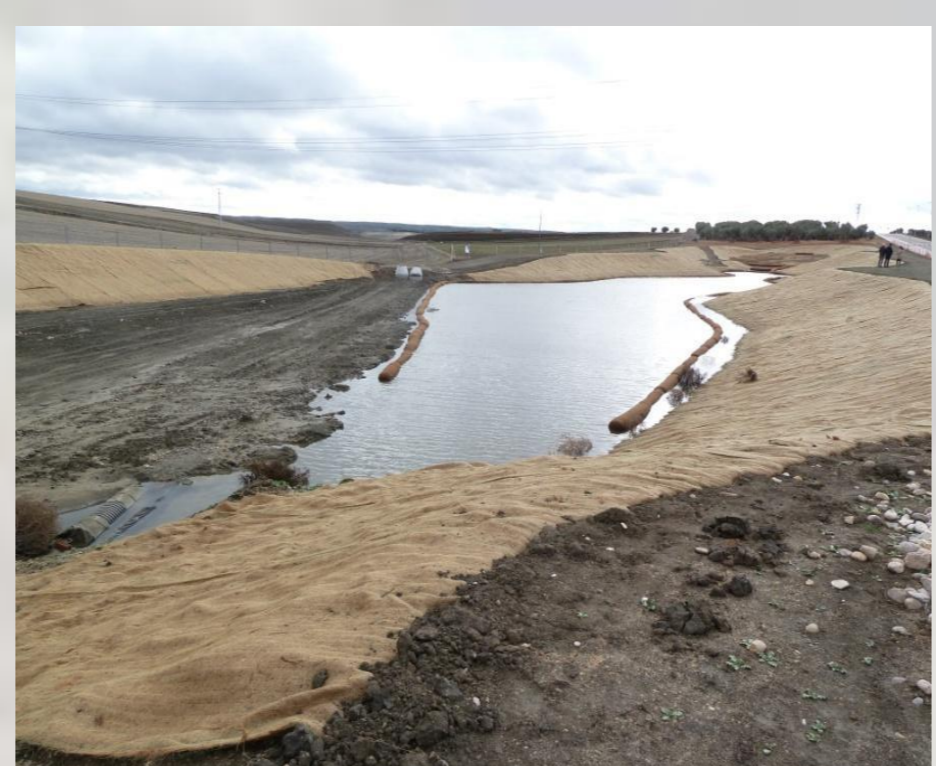
Figura 9. Colocación de manta de coco.
