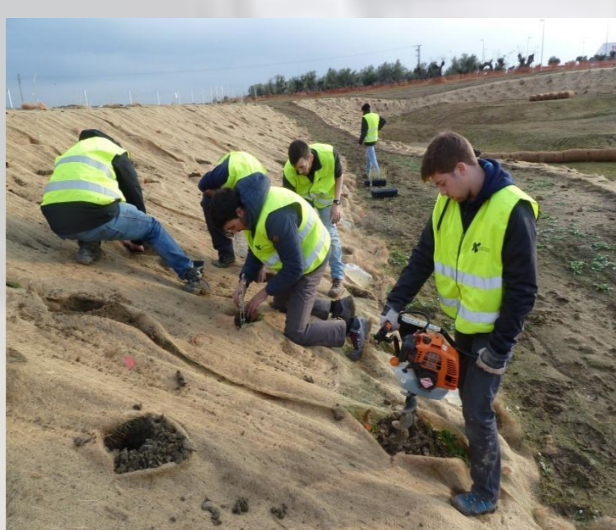
Figura 10. Preparación de agujeros profundos.
